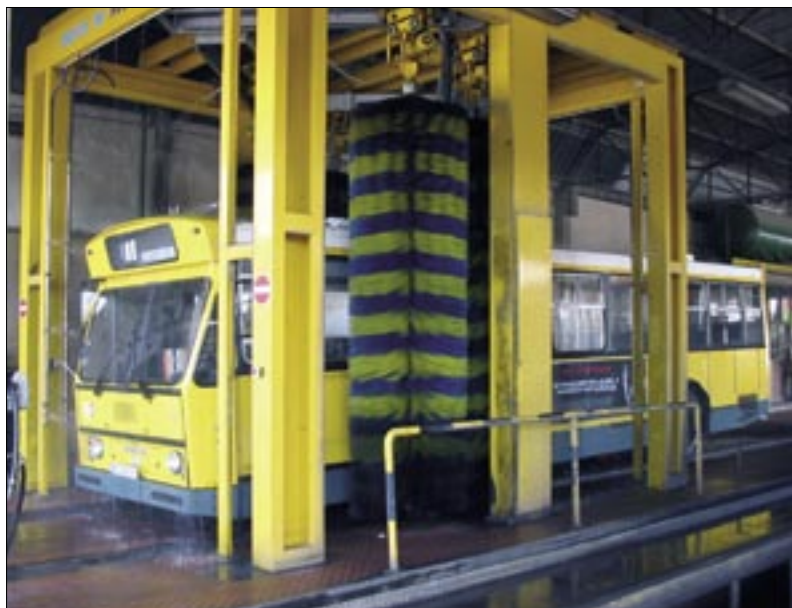
Portal-Estación de lavado para ómnibus
